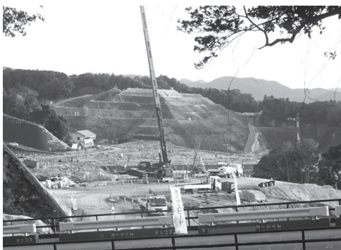
君津環境整備センター、通称「アラックス」。山を切り崩し、拡張工事が続けられています
