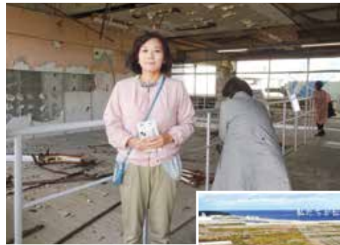
津波で破壊された教室など、当時のまま残されています。
