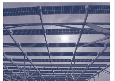
下から見上げた両面ソーラーパネル。間隔が広いので、作物に十分な日照を確保できます。
